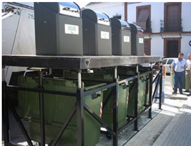
Εικόνα 61: Σύστημα υπογειοποίησης τεσσάρων υφιστάμενων κάδων
